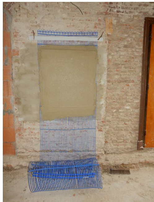
Proefvlak aanbrengen klimaatmatten
